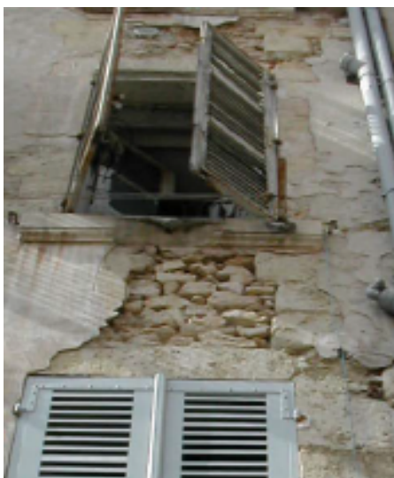
Enduit décrouté, moellons mis à nu
