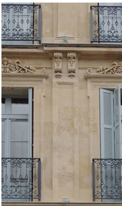
Pierres de taille posées en assise
