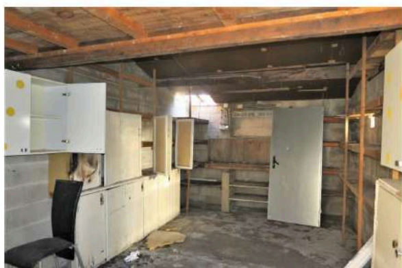
Vue intérieure sur le pignon arrière
