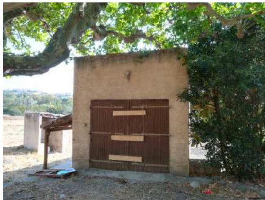
Bâtiment 2 (20m 2 ) – parcelle C86
